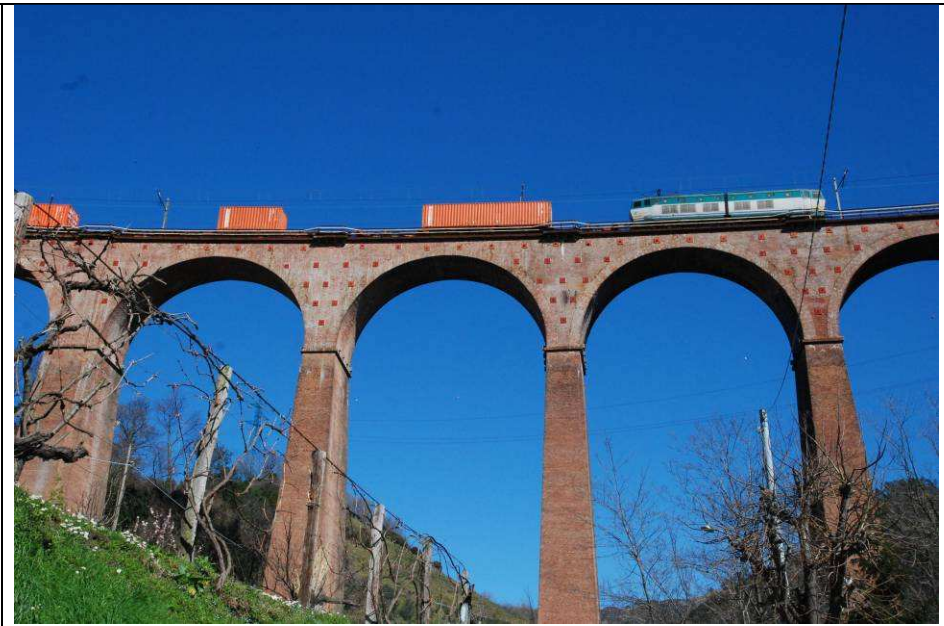
Uno storico viadotto ferroviario in muratura domina il paesaggio anche da lontano.
