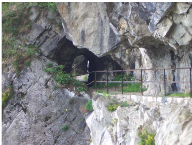
Figura 3 - Tratto scavato nella roccia
